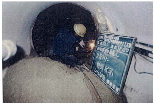
(既設立坑)ラナープレート切断状況
